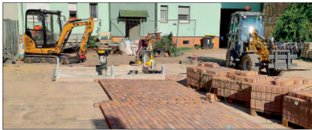
■ Das „Erdmänner-Team“ erledigt eine große Vielfalt von Erdbau-, Pflaster- und Abrissarbeiten.
