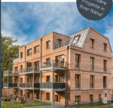
Bahnhofstraße in Dahlewitz
