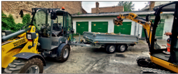
■ Das „Erdmänner-Team“ erledigt eine große Vielfalt an Erdbau-, Pflaster- und Abrissarbeiten.
